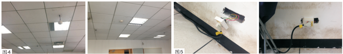
图4 E1305脱落的2个烟感已固定 图5 F410已修理脱落的墙插
