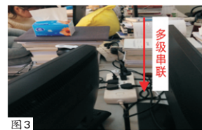
图3 F413已实施改造保证每个座位有独立插座 (房间责任人同时改造了所属F414与F501)
