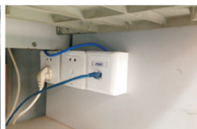
图3 F413已实施改造保证每个座位有独立插座 (房间责任人同时改造了所属F414与F501)
