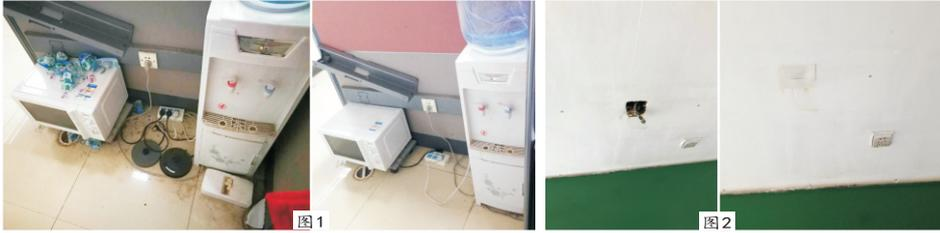
图1 C109已打扫微波炉周边卫生并移走2个电热壶防止电力超载 图2 E1区1楼墙面的裸露电线已包裹并做封闭处理
