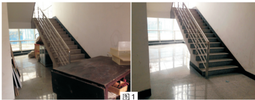
图1 H区1楼东侧的杂物已清理
